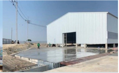
โรงประกอบเหล็กเสริมที่พานทอง
