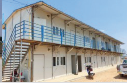
งานก่อสร้างบ้านพักคนงานที่เปรง
