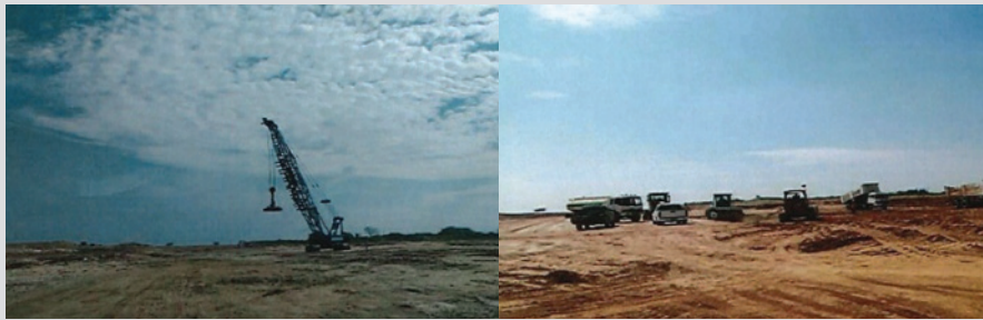
รูปภาพการปรับปรุงพื้นที่สำหรับก่อสร้างทางขับระยะที่ 1 และลานจอดของศูนย์ซ่อมอากาศยาน
