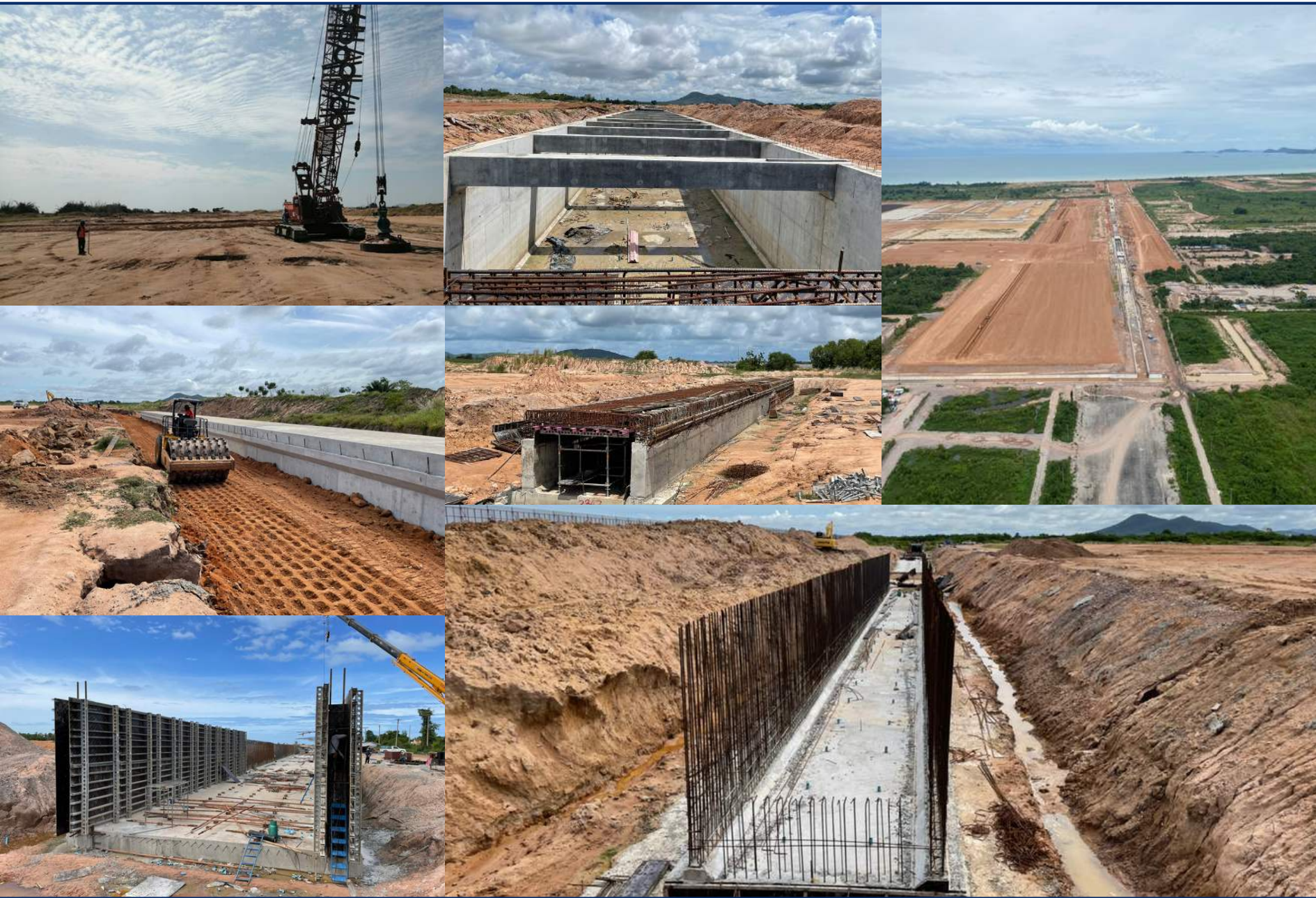
งานปรับพื้นที่สำหรับก่อสร้างทางขั้ระยะที่ 1 และลานจอดศูนย์ซ่อมบำรุงอากาศยาน แล้วเสร็จ กันยายน 2565
