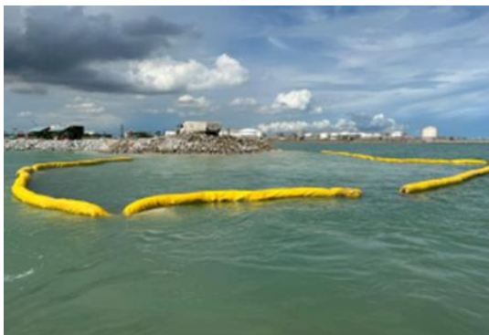
ภาพการติดตั้งม่านกันตะกอนบริเวณพื้นที่การวางหินสำหรับเขื่อนกันทราย
