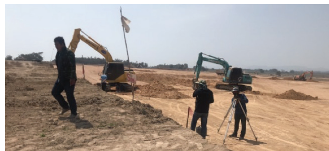
ภาพการเตรียมการในพื้นที่ก่อสร้างระบบประปาและระบบบำบัดน้ำเสีย
