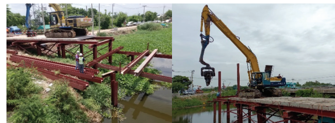
ภาพงานติดตั้งสะพานชั่วคราวเพื่อลำเลียงวัสดุก่อสร้าง บริเวณคลองพระองค์ไชยานุชิต จ.ฉะเชิงเทรา และคลองพานทอง จ.ชลบุรี
