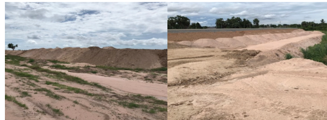
ภาพการปรับระดับดินในพื้นที่ก่อสร้างระบบไฟฟ้าและน้ำเย็น
