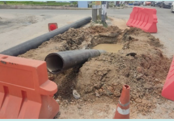
ภาพการเจาะตอมุดท่อลอดประปาของการประปาส่วนภูมิภาคบริเวณ อ.บางละมุง จ.ชลบุรี
