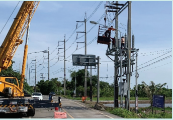
ภาพการเชื่อมสายเคเบิลใต้ดินระบบ 115 เควี บริเวณคลองก้าน จ.ฉะเชิงเทรา
