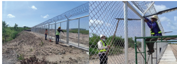
ภาพการก่อสร้างรั้วมาตรฐานเขตการบินชั่วคราว
