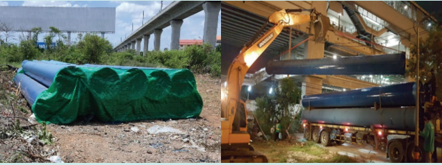
ภาพการรื้อย้ายท่อน้ำประปาใต้ดินบริเวณสถานีรถไฟแอร์พอร์ต เรลลิงก์
