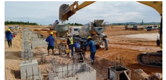
ภาพงานก่อสร้างระบบระบายน้ำ
