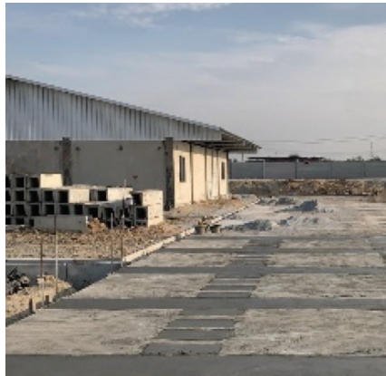
งานปูวัสดุพื้นทางหินคลุก งานก่อสร้างโรงหล่อชิ้นส่วนที่ พานทอง งานก่อสร้างโรงหล่อชิ้นส่วนที่ บางละมุง การเข้าพื้นที่เตรียมการเพื่อการออกแบบและก่อสร้างโครงการเกี่ยวกับรถไฟก่อนวันที่เริ่มต้นนับระยะเวลาโครงการ (Early Works)
