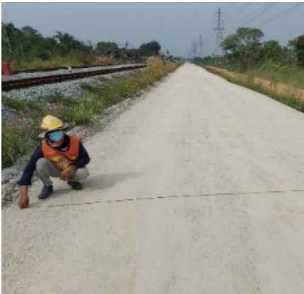
งานปูวัสดุพื้นทางหินคลุก งานก่อสร้างโรงหล่อชิ้นส่วนที่ พานทอง งานก่อสร้างโรงหล่อชิ้นส่วนที่ บางละมุง การเข้าพื้นที่เตรียมการเพื่อการออกแบบและก่อสร้างโครงการเกี่ยวกับรถไฟก่อนวันที่เริ่มต้นนับระยะเวลาโครงการ (Early Works)
