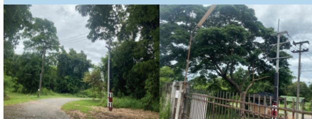
ภาพการดันท่อร้อยสายไฟฟ้าใต้ดิน บริเวณค่ายลูกเสือชราวุธ
