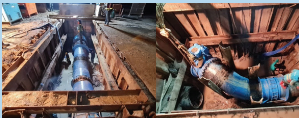
ภาพการรื้อย้ายท่อน้ำประปาใต้ดิน บริเวณสถานีรถไฟแอร์พอร์ต เรลลิงก์
