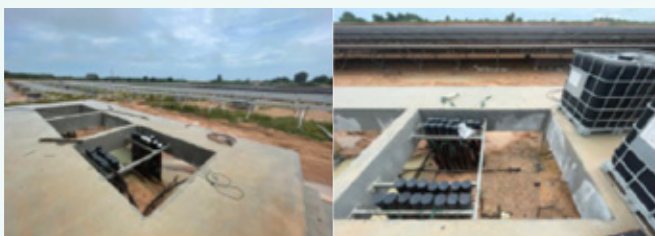
งานติดตั้งท่อร้อยสายไฟฟ้า
