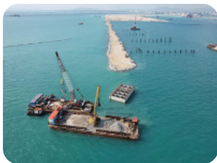
งานก่อสร้าง Caisson
