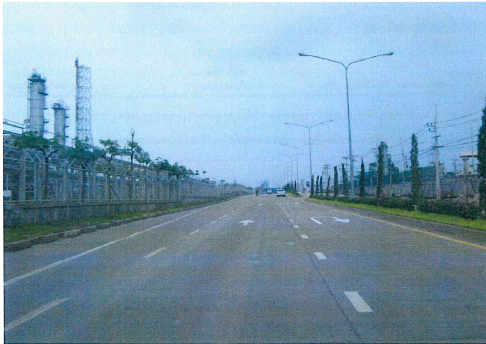
ถนนภายในนิคมอุตสาหกรรม
