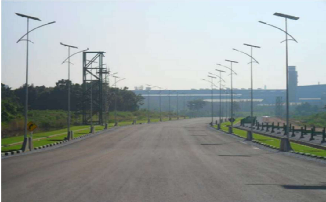
รูปที่ 14 ถนนสายรองและไฟฟ้าแสงสว่างแบบ Solar Cell
