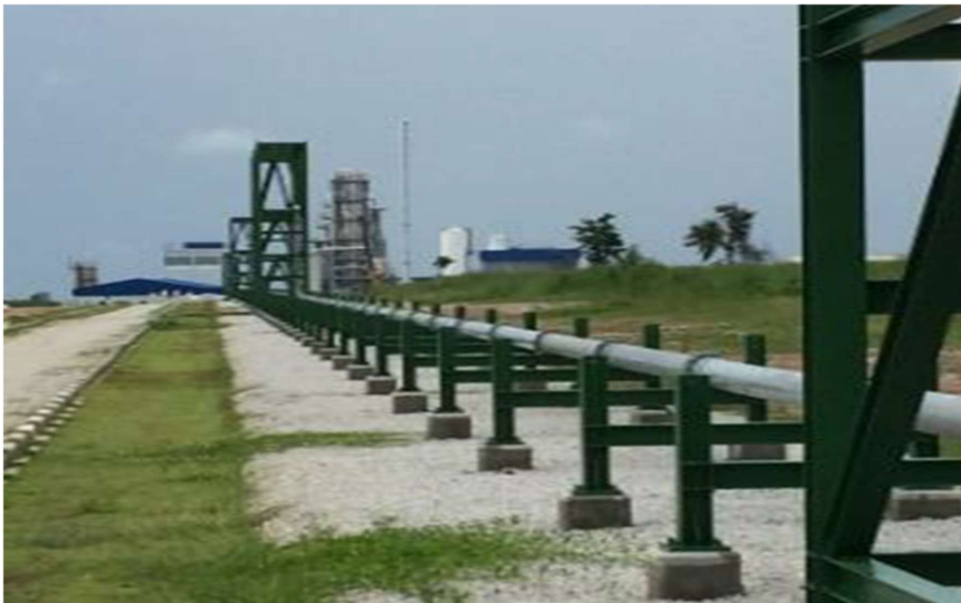
รูปที่ 15 คานรองรับท่อ (Pipe Rack) สำหรับวางท่อผลิตภัณฑ์และสาธารณูปโภค
