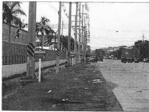
ป้ายแสดงตำแหน่งท่อก๊าซ (Pipeline Marker)
