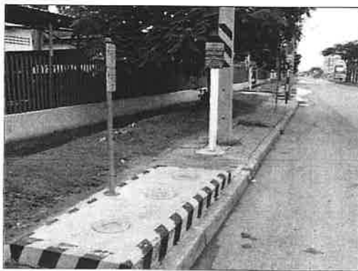
บ่อวาล์วของระบบท่อก๊าซธรรมชาติ (Mainline Valve Pit)
