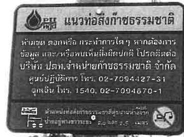
ป้ายแสดงตำแหน่งท่อก๊าซ (Pipeline Marker)
