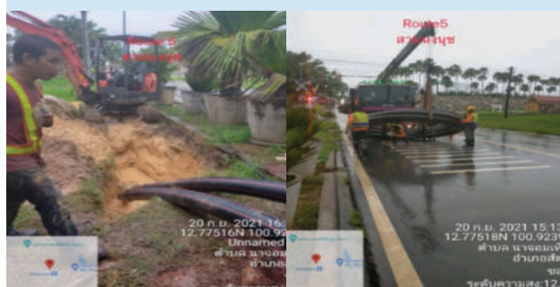
ภาพการดันท่อร้อยสายไฟฟ้าใต้ดิน บริเวณสวนนงนุช
