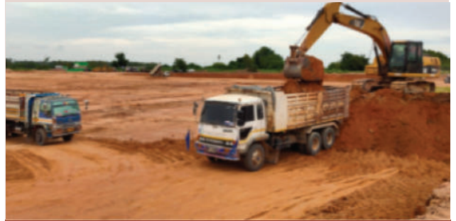
ภาพการขุดปรับดินในพื้นที่ก่อสร้าง ระบบไฟฟ้าและน้ำเย็น
