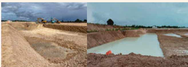
ภาพงานเปิดหน้าดินและขุดดินเพื่อก่อสร้างถังน้ำใส ประมาณ 20,000 ลบ.ม.
