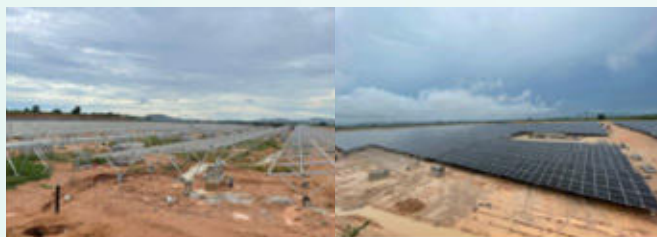
งานติดตั้ง PV Module
