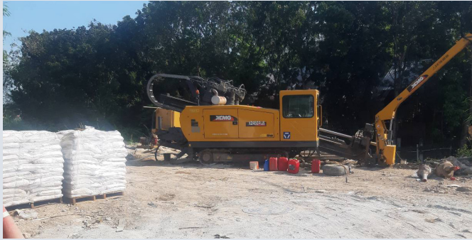
ภาพการเจาะดึงท่อลอดประปาของการประปาส่วนภูมิภาค บริเวณสายหนองจับเต่าและถนนสายวัดญาณสังวราราม
