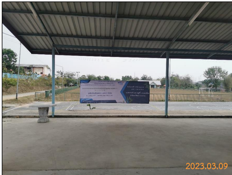
บริเวณศาลาสร้างสุข หมู่ที่ 2 บ้านซอย 8
